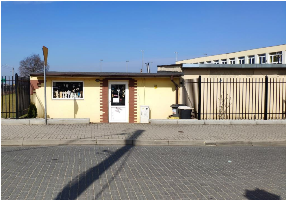
Fot. nr 1 Budynek przeznaczony do rozbiórki – widok od strony ulicy Szkolej.
